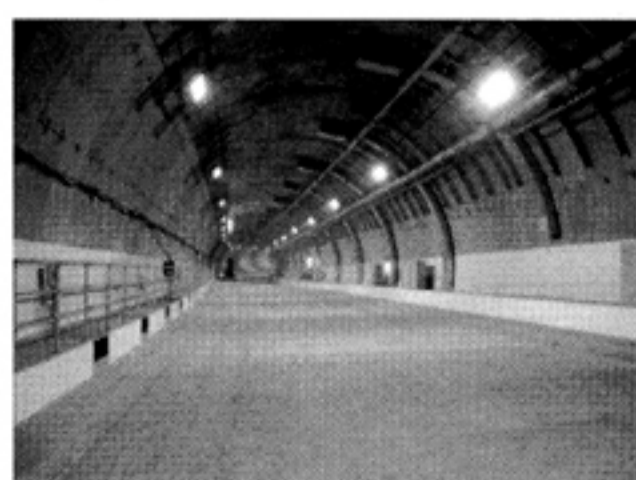
山手通りの下に建設中の首都高
