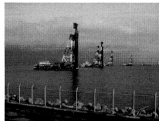
海底で地盤改良工事中です
